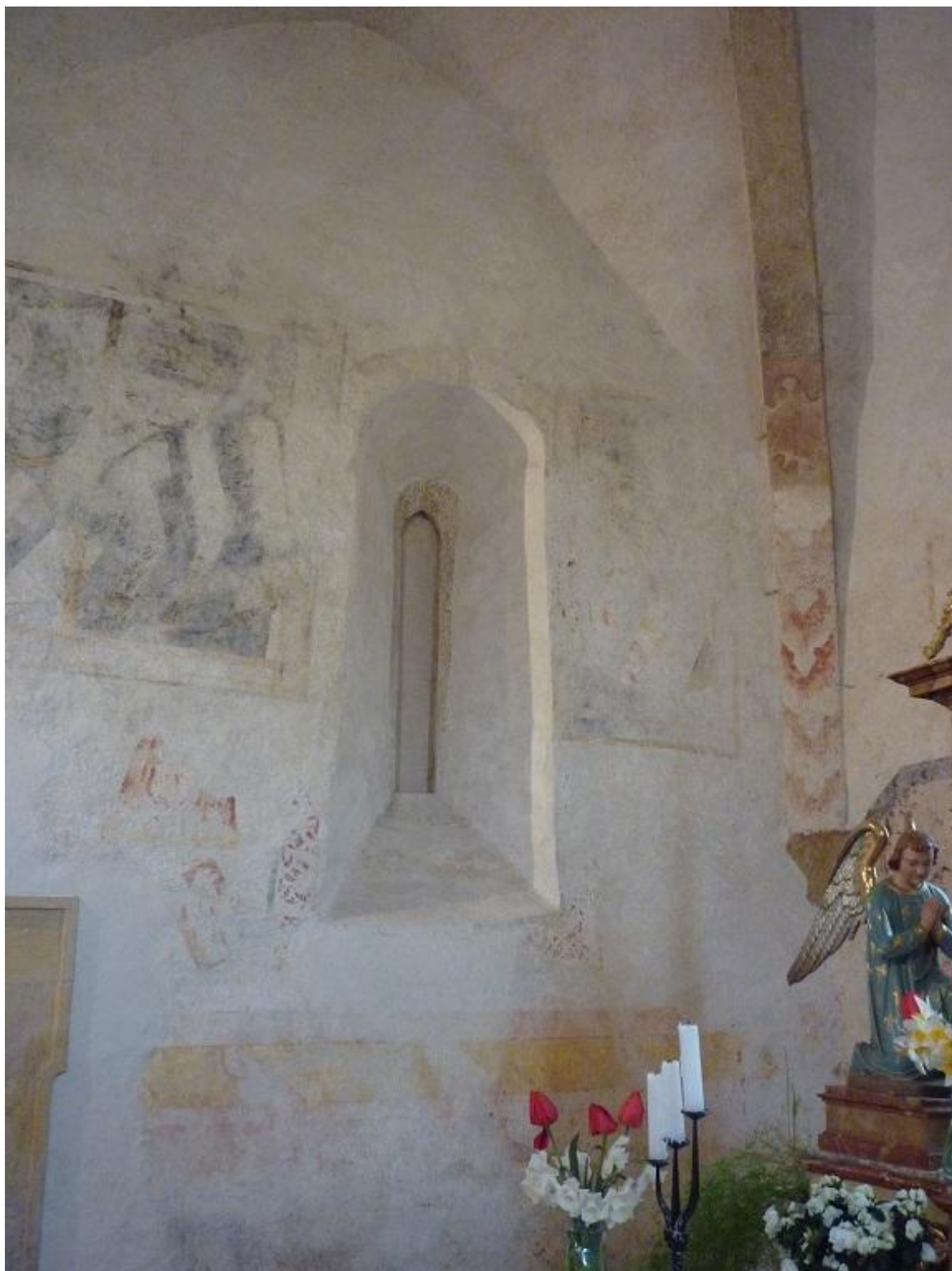
Příloha č. 8 Kostel: původní štěrbinové okno (presbytář, severní stěna).
