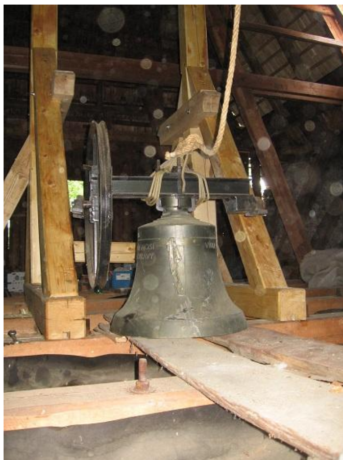
Příloha č. 25 Zvon: špatně provedené upevnění do krovu.
