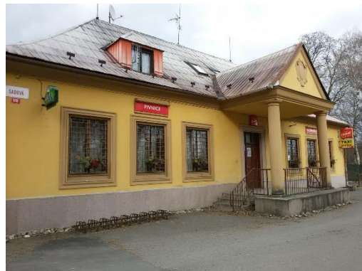
Obr. 6. Budova Na Střelnici
