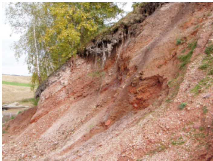
Obr. 2 Lokální sesuv na západním svahu haldy Kukla (zdroj: Svoboda 2010)
