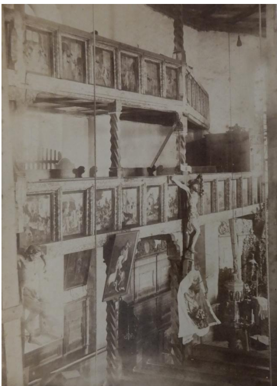
[2] Původní evangelický kostel Božího Těla, interiér kostela – empora
