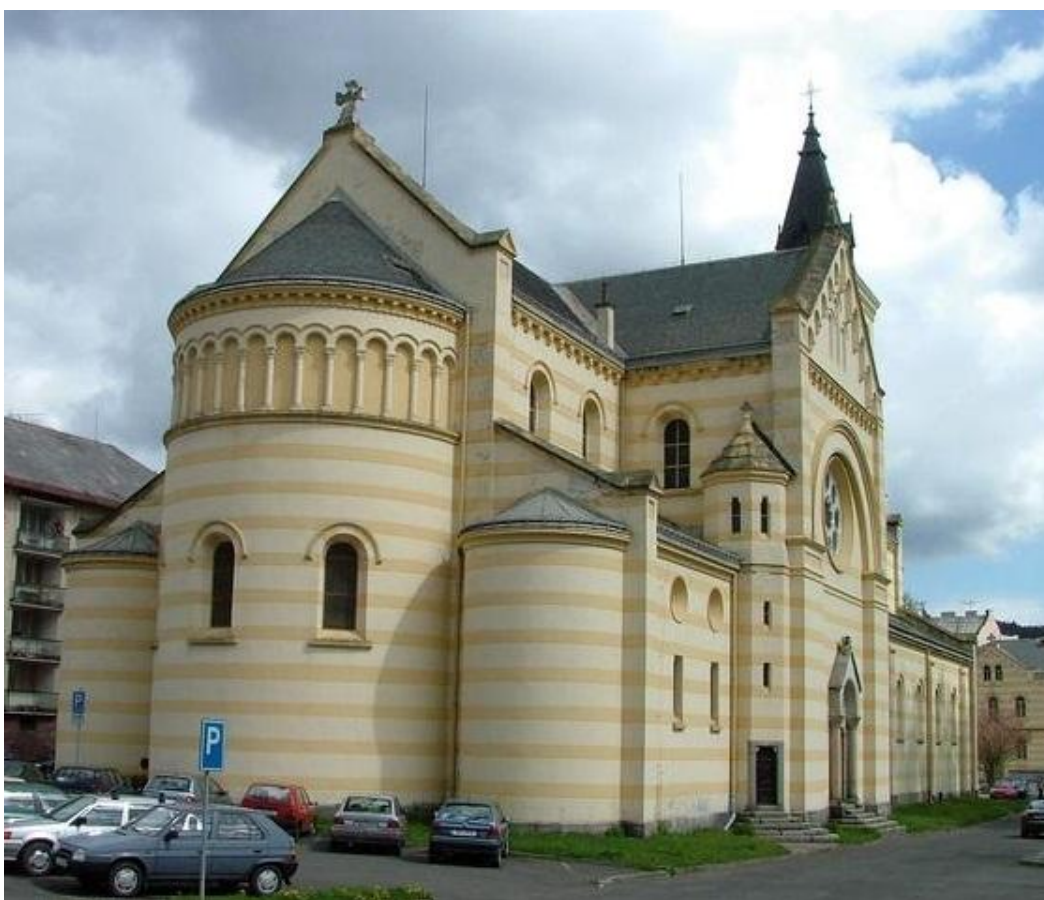
[39] (Ludvík Lábler), Kostel Božího Těla – pohled na apsidy, 1892–1896
