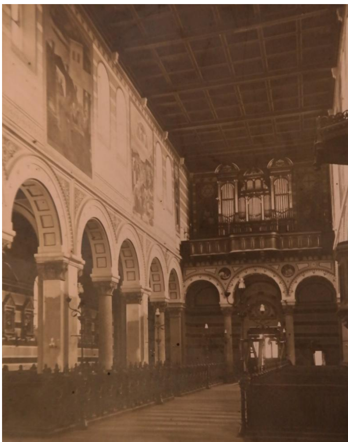
[34] Interiér kostela – celkový pohled směrem na kůr
