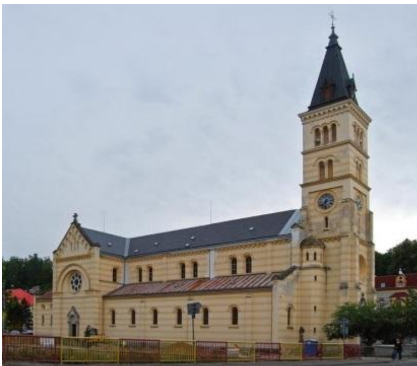
[38] (Ludvík Lábler), Kostel Božího Těla – boční pohled, 1892–1896
