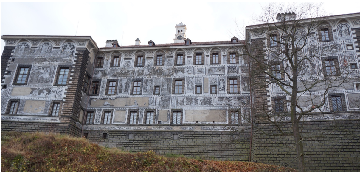
Obr. [22] Severní průčelí zámku Nelahozeves.
