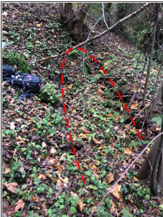
Obr. 13. Terénní deprese (vznačena červeně) představující zasypáný vchod do štolý Nová Josefa v hornoměstském revíru. Foto: Z. Juránková, listopad 2019.
