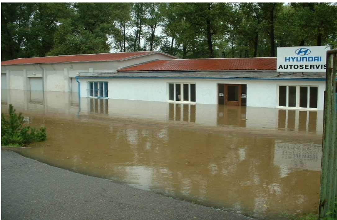
Obr. č. 6. Zaplavený autoservis. Povodně v Českých Budějovicích v roce 2002.
