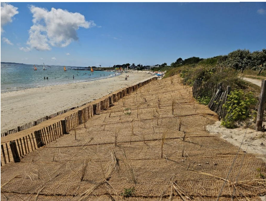
(Obr.17) Ochrana pobřeží proti erozi vegetací
