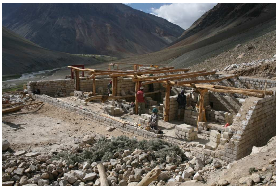
Obrázek č. 10: Vznik hrubé stavby budovy školy. (se svolením autora)
