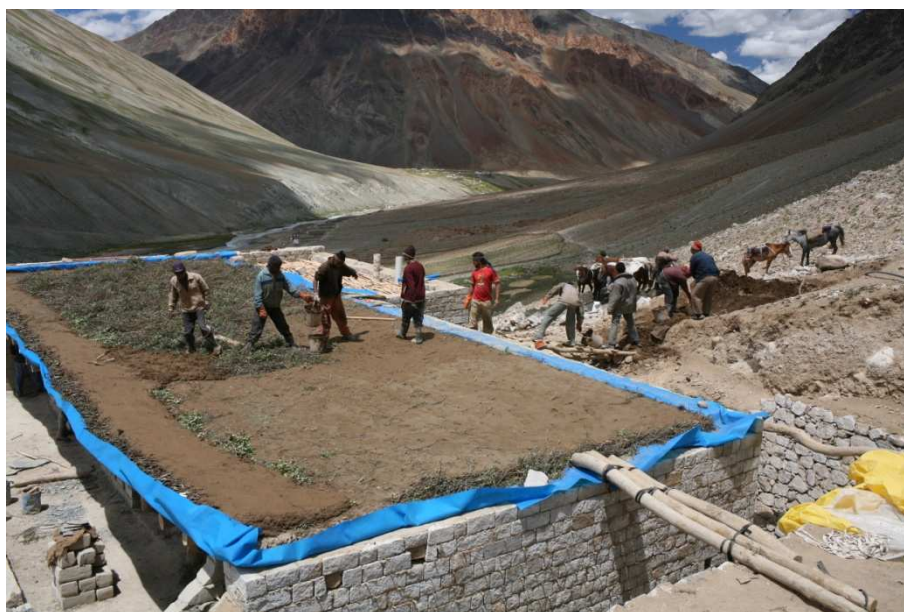
Obrázek č. 11: Pokrytí střechy. (se svolením autora)
