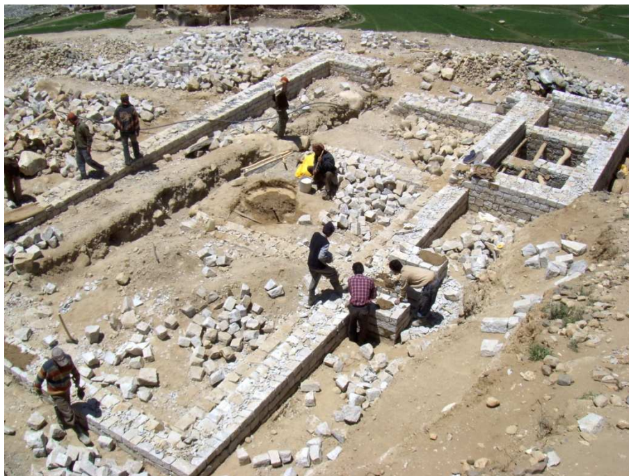
Obrázek č. 9: Hotové základy a první řady nosného zdiva.
