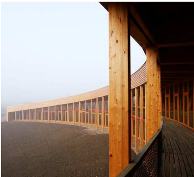
Obrázek č. 3: Nadzemní nosná fošnová konstrukce. Centrum ekologických aktivit města Olomouce, Sluňákov. (Projektil Architekti, 2007)
