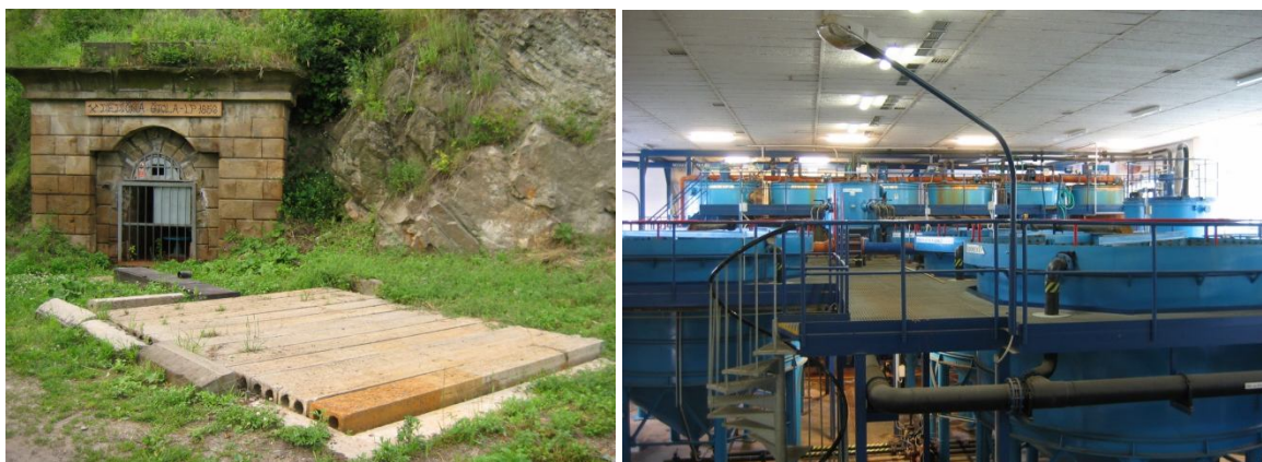
Obrázek 4: Vstupní průčelí dědičné štol a výtok vody pod betonovým krytem do ČDV (vlevo) a interiér ČDV Oslavany s usazovacími nádržemi (vpravo). Foto Ivo Medřík 14. 6. 2004
