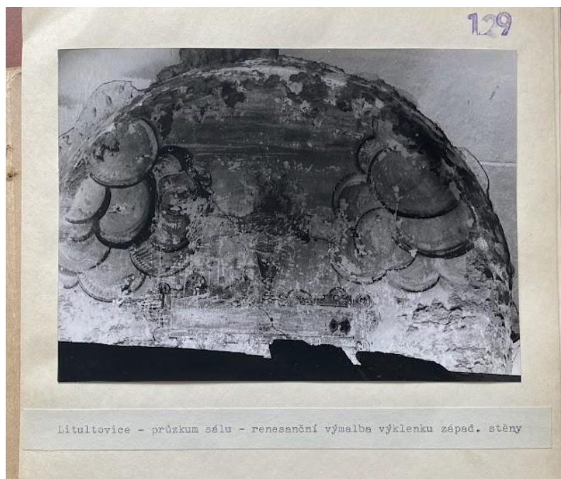
Obr. IV. Reprezentační sál „nového“ zámku v Litultovicích, výklenek na západní stěně, stav před restaurováním
