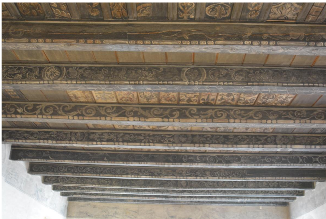
21. Řazení litultovického záklopového stropu tzv. na sráz, reprezentační sál „nového zámku, 1609, Foto: Beata Krajčíková
