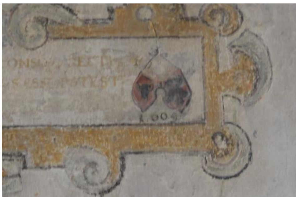
Obr. XV. Reprezentační sál „nového“ zámku v Litultovicích, detail výklenku západní stěny, současný stav
