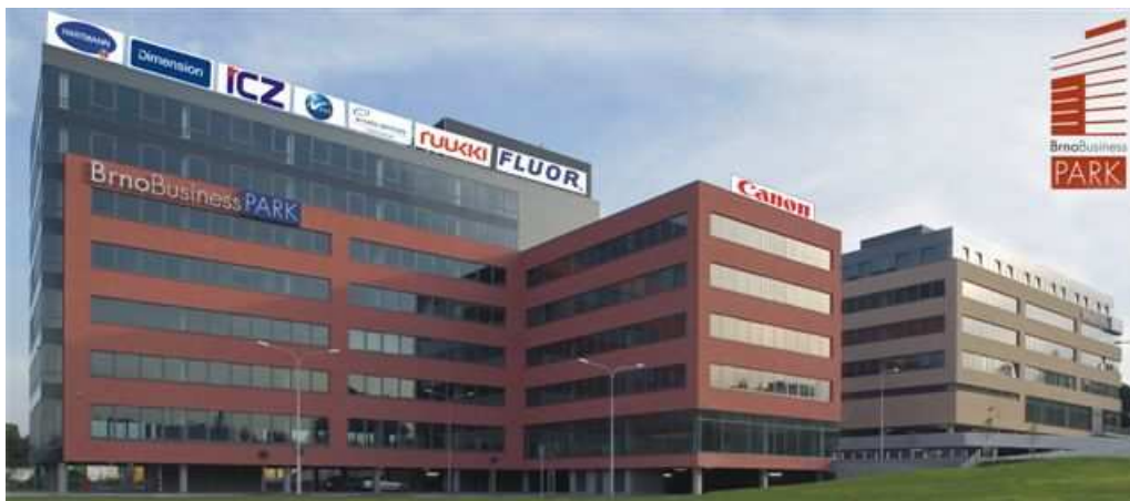
Obrázek 2 - Brno Business Park – administrativní suburbanizace
