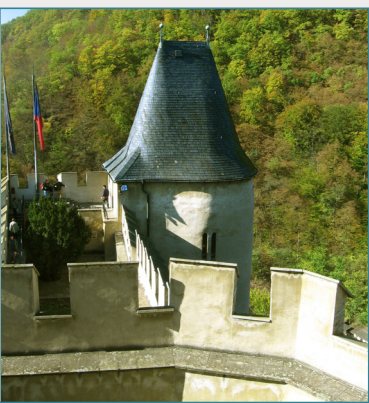
Studniční věž [KA10]
