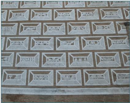
Psaníčka na průčelí [LI11]
