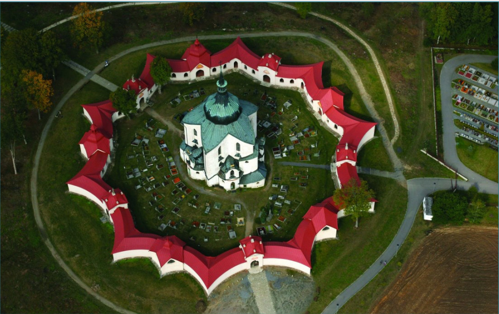
Letecký pohled na areál [ZH6]
