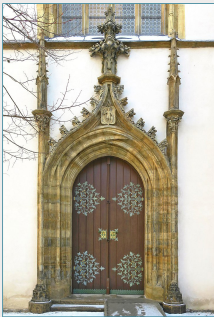
Vstupní dveře do chrámu po restaurování [MO4]
