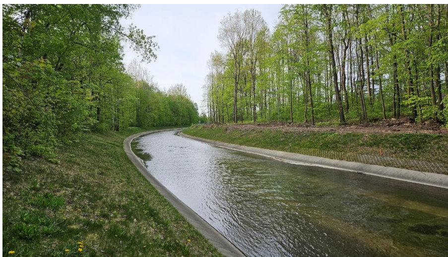
Obrázek 10: Betonové koryto přivaděče Morávka-Žermanice (Heryánová, 2024)
