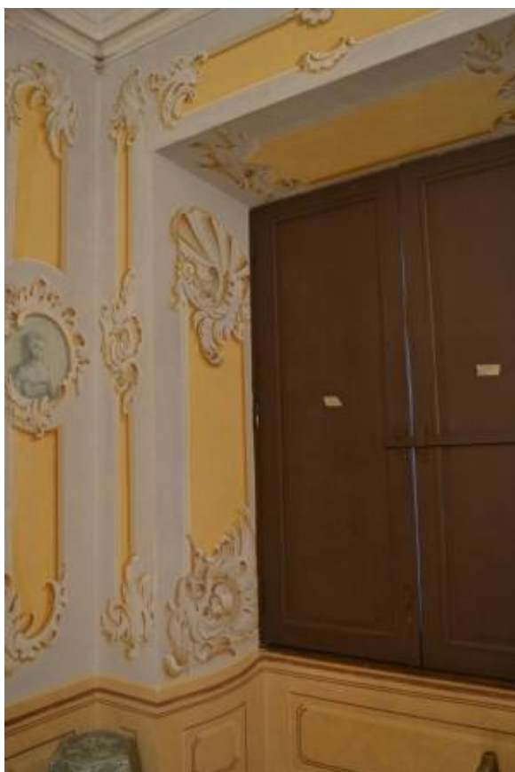
Obr. 43 Rokajová ucha v ostění oken rohového hudebního salónku
