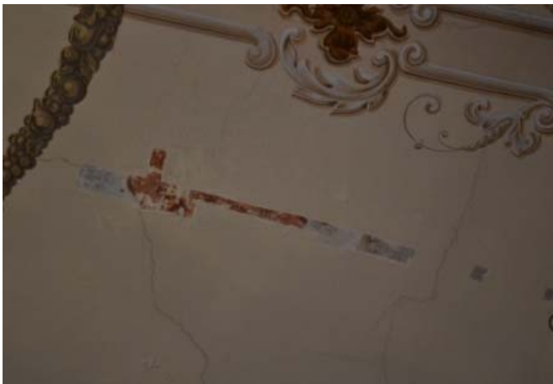
Obr. 20 Restaurátorská sonda v letní jídelně
