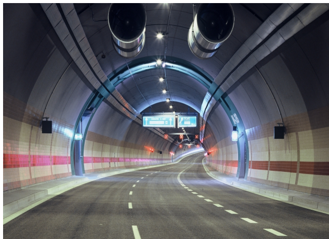
Obrázek 2.10: Tunel Mrázovka, Zdroj: http://www.satra.cz/tunel-mrazovka/
