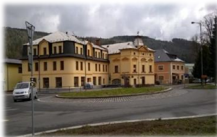
Obr. 29: Pohled na bývalý hotel Morava dnes (současnosti jsou tyto prostory k prodeji).
