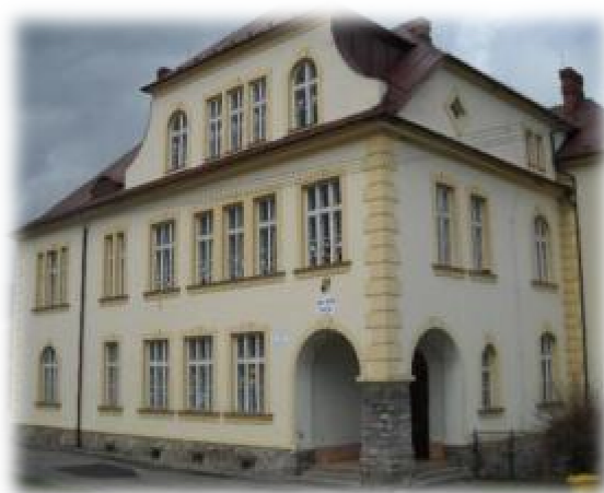
Obr. 35: Budova dnešní základní školy.
