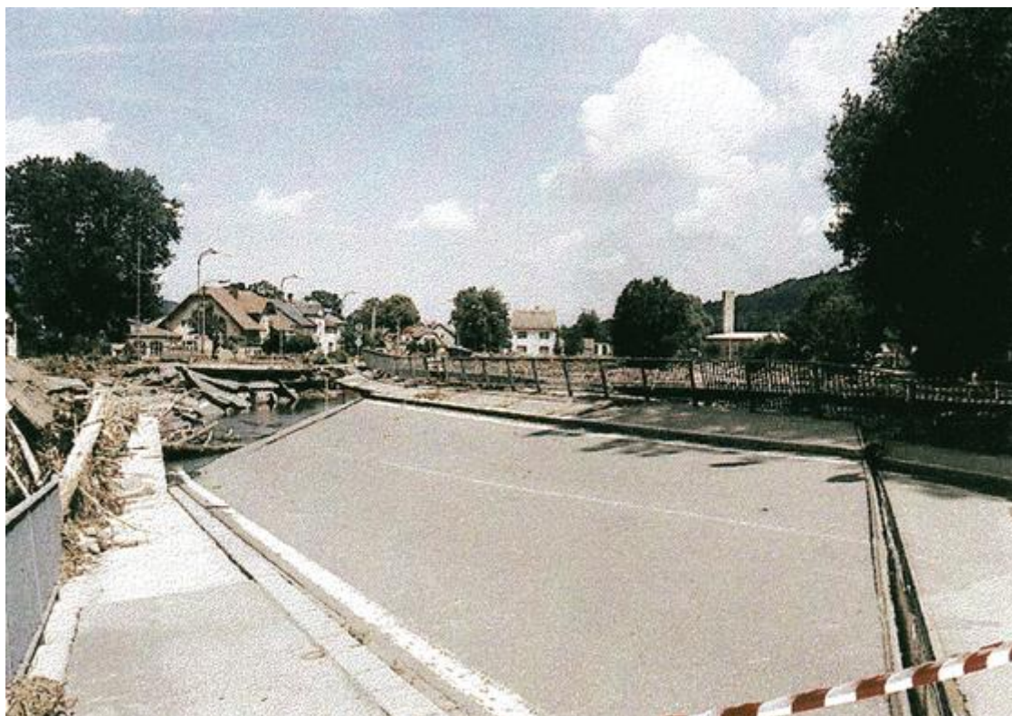
Obrázek 7. Stržený most vedoucí přes řeku Bělou v České Vsi ( https://www.edpp.cz ).
