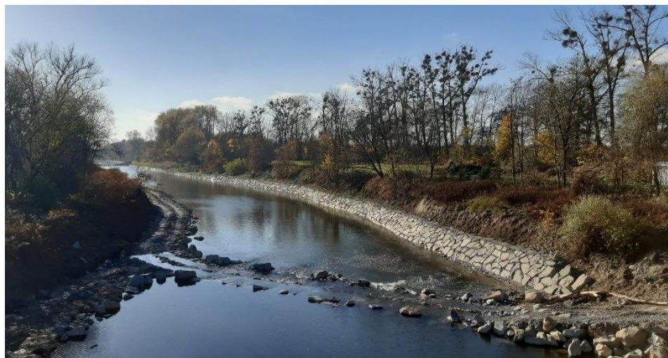
Obrázek 28: Tvrdá regulace koryta toku u Oseku nad Bečvou
