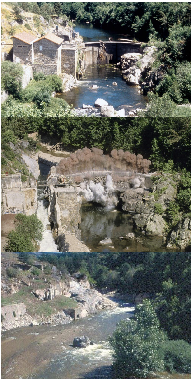
Obrázek 14: Stav před, během a po odstranění přehrady Saint-Etienne-du-Vigan v roce 1998
