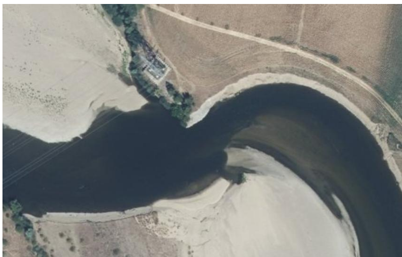
Obrázek 18: Stožár vysokého napětí mezi obcemi Chemilly a Toulon-sur-Allier s opevněním proti erozi
