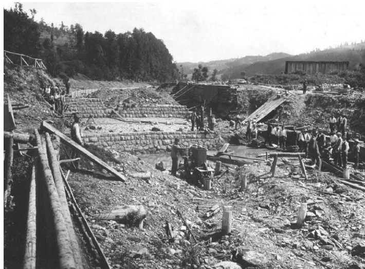
Obrázek 24: Probíhající práce na kamenné regulaci Bečvy na počátku 20. století
