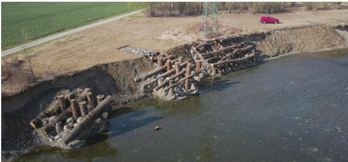
Obrázek 29: Přírodě blízká stabilizace břehu Bečvy u stožáru vysokého napětí
