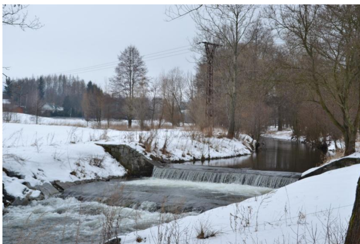
Obr. 22 Stabilizační stupeň vybudovaný nad městem Štíty (pořízeno 21.3.2013)
