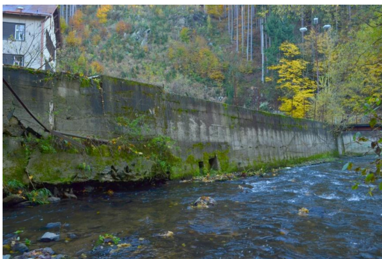
Obr. 26 Betonové opevnění břehové linie v dolní části toku (20 m pod firmou Renostav) (pořízeno 19.10.2012)
