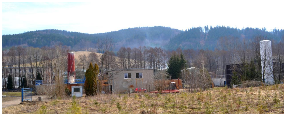
Obr. 7 Čistírna odpadních vod v Bílé Vodě (pořízeno 16.4.2013)
