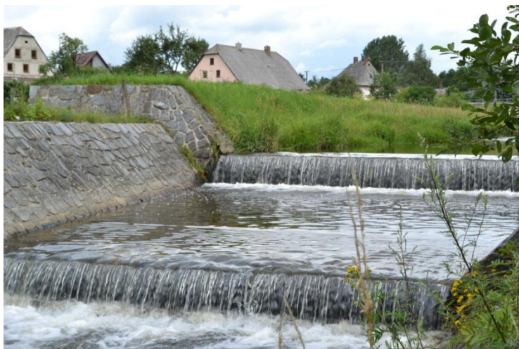
Obr. 21 Stabilizační stupeň vybudovaný v obci Bílé Vodě (pořízeno 20.7.2012)
