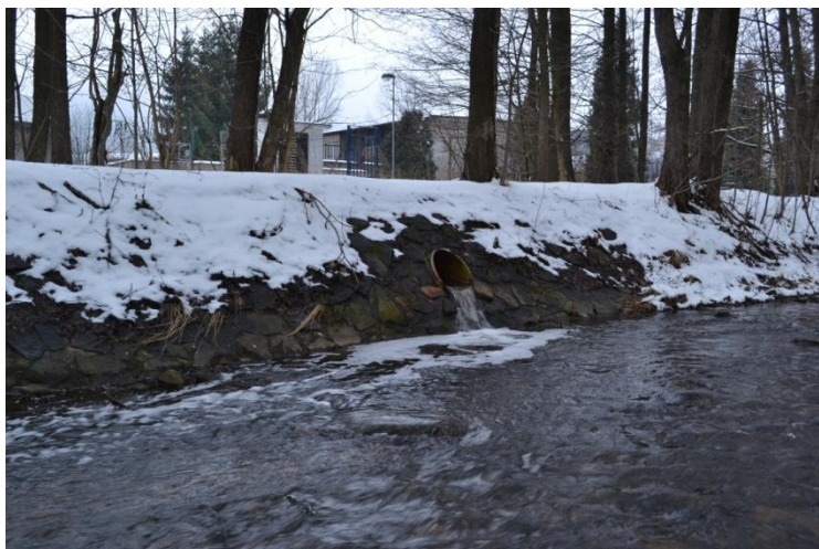
Obr. 27 Vypouštění odpadních vod z čistírny odpadních vod v Bílé Vodě do recipientu (pořízeno 15.2.2012)
