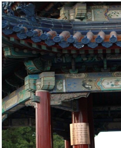
Obr. 2.2-2: Spoj nosných ramien medzi strechou a stĺpom, altánok pri Oltári Nebies, Peking, Mária Mokošová, 1 Oct. 2011, JPEG súbor.
