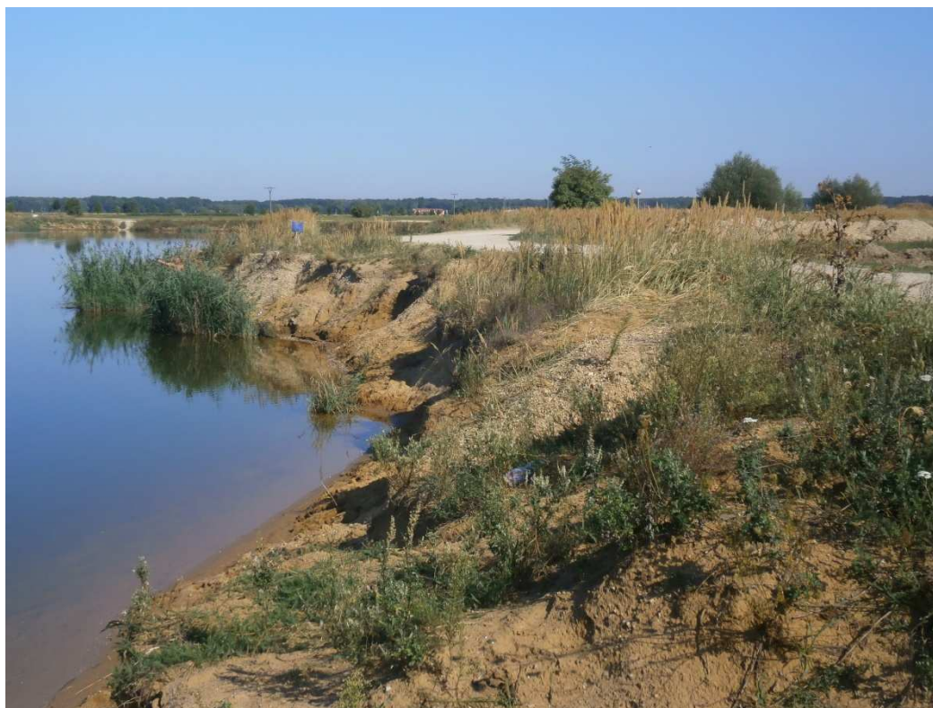
Příloha č. 2: Východní břeh pískovny Veltruby (foto: Jiří Pospíšil, červenec 2013).
